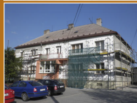
Budova obecního úřadu se v r. 2012 dočkala rekonstrukce - byla zateplena fasáda, vyměněna okna a vybudována bebariérová rampa u vstupních dveří..
